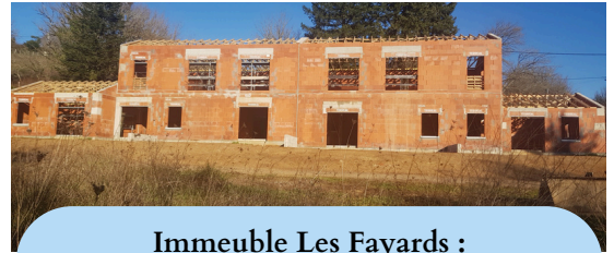
Immeuble Les Fayards : Le chantier avance...
